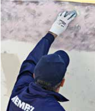
Spachteln entlang der Wasserlinie
