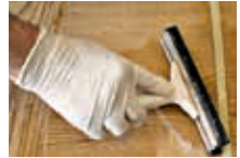
Verschmutztes Wasser entfernen
