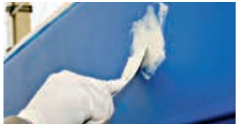
Einzelne Stellen mit Spachtelmesser bearbeiten
