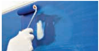
Primer auf einzelne Stellen auftragen
