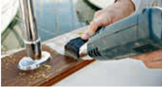
Alten Lack mit Heißluftpistole entfernen
