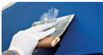
Fill using blade
