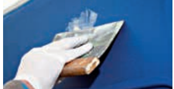
Enmasillado con el uso de una llana
