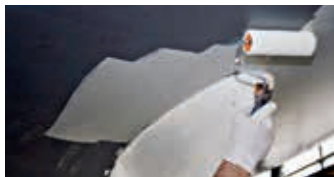
Aplicación del antiincrustante sobre la imprimación.
