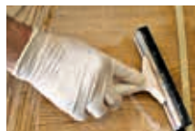
Eliminar agua sucia y restos de lijado
