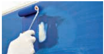
Aplicación de la imprimación sobre la zona reparada
