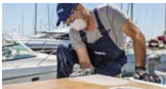
Lijado de la superficie
