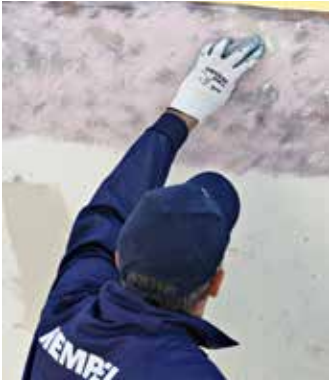
Enmasillado en la línea de flotación
