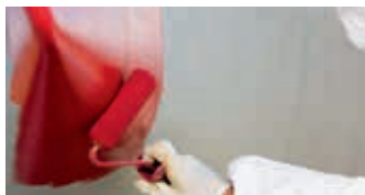
Aplicación del antiincrustante
