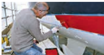
Aplicación en la línea de flotación
