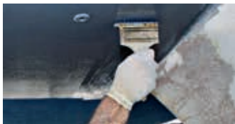
Pour la finition de surface de Hempel's High Protect II, passer le pinceau dans le sens inverse
