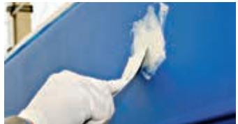
Traiter avec un couteau à enduire par endroits
