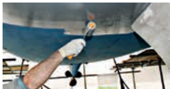
Appliquer Hempel's High Protect II avec un rouleau en mousse
