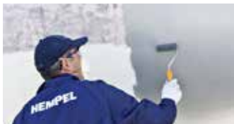
Application de Hempel's Underwater Primer sur la surface préparée
