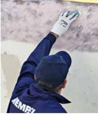
Masticage au-dessus de la ligne de flottaison
