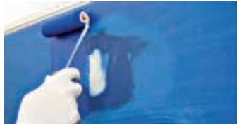
Mjestimično nanošenje temeljnog premaza
