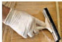
Uklanjanje onečišćene vode
